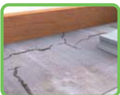
Calafateo de Grietas
