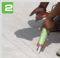
2 Resanar grietas con en sellador de poliuretano Al-Seal.
