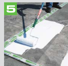
5 Aplicar una capa de Al-Flex Pro y dejar secar (26m 2 por cubeta sobre superficie lisa).
