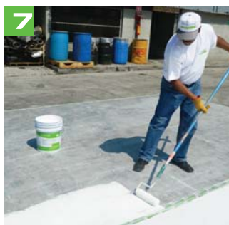
7 Colocar una capa de Elastik en un solo sentido [ \frac{1}{2} L. x m 2 ] y dejar secar
