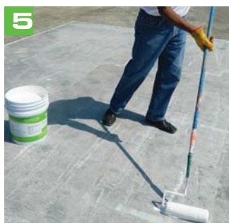
5 Colocación de Primario hecho con Elastik relación 1:4 con agua y dejar secar
