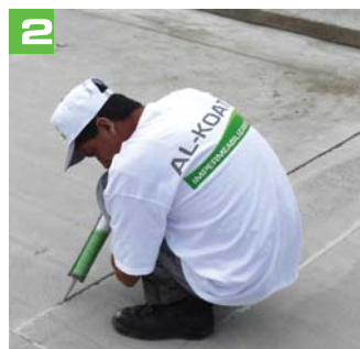
2 Resanar grietas con sellador Al-Seal
